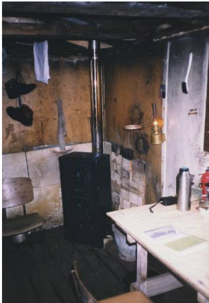
En ny brændeovn er sat til erstatning for den gamle ubrugelige. Ovnens lov at køre på fuld tryk, så huset blev tørret godt ud. Den gamle loftsbeklædning er revet ned, så bjælkerne nu er synlige. Gulv og vægge er vasket af for mug og snavs.
