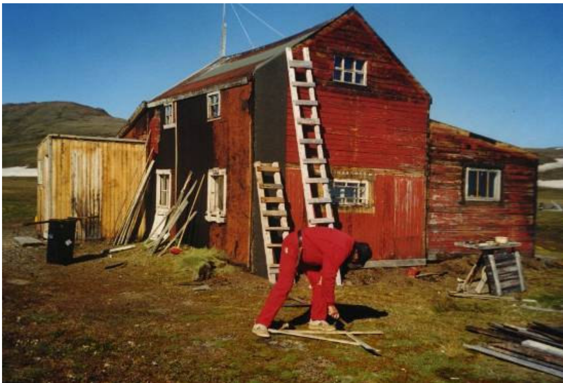
Sådan så Myggbukta ud kort efter ankomsten. Arbejdet er begyndt. Pappen er fjernet fra vindfanget. Den første bane tagpap er sømmet på sydgavlen. Tagvinklen måles op.
