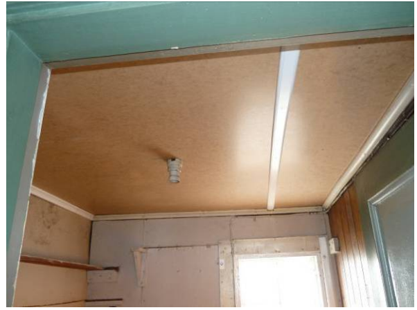
T.v. I flere af rummene i Ørnereden havde bjørnen ødelagt loftpladerne i 2013. T.h. Nye loftplader er blevet monteret og klar til bemaling.
