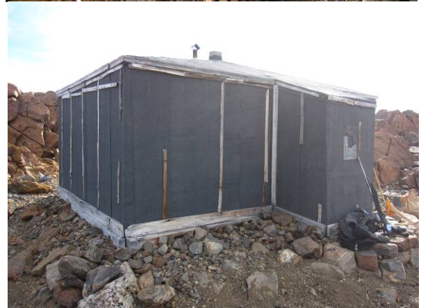
Udenpå væggenes tagpap blev derpå opsat de oprindelige lister m.m. præcist hvor de tidligere havde siddet.
