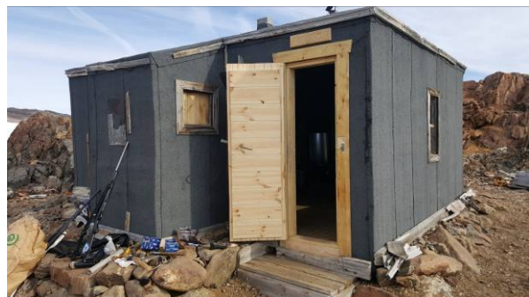
Overpappet blev smeltet på med overlap under hensyntagen til vand ovenfra og de fremherskende vindretninger (NØ og SV).
