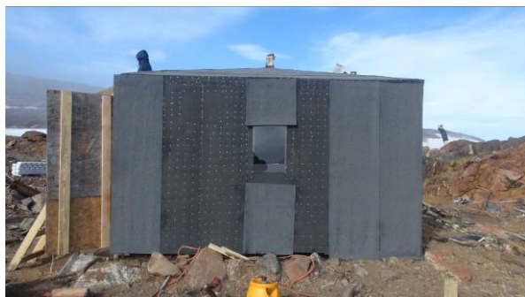
Overpappet blev smeltet på med overlap under hensyntagen til vand ovenfra og de fremherskende vindretninger (NØ og SV).
