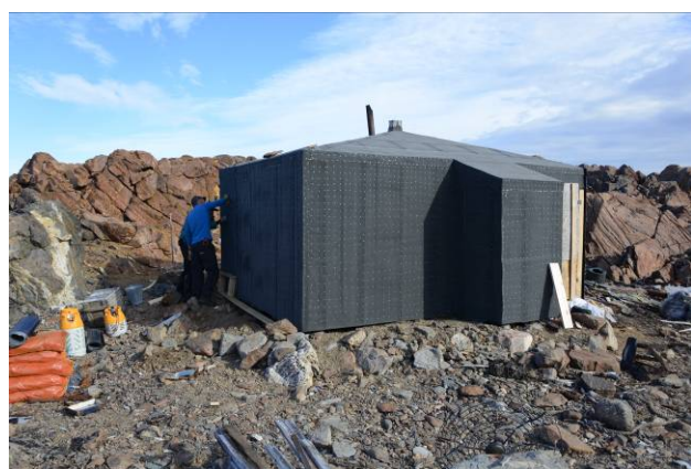
Vægge og tag blev beklædt med underpap, som blev sømmet på med 25 mm papsøm. 18.000 papsøm blev det til, med 5 cm mellemrum.
