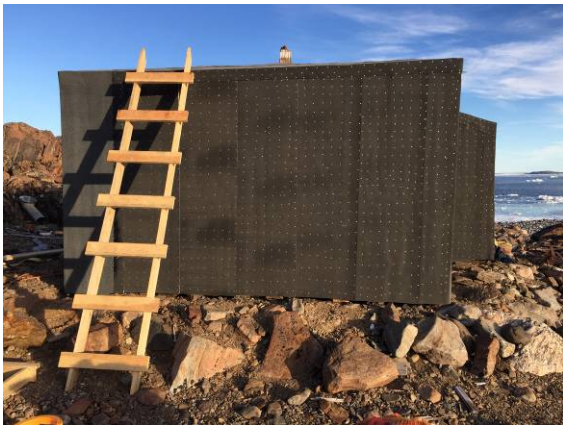
Vægge og tag blev beklædt med underpap, som blev sømmet på med 25 mm papsøm. 18.000 papsøm blev det til, med 5 cm mellemrum.
