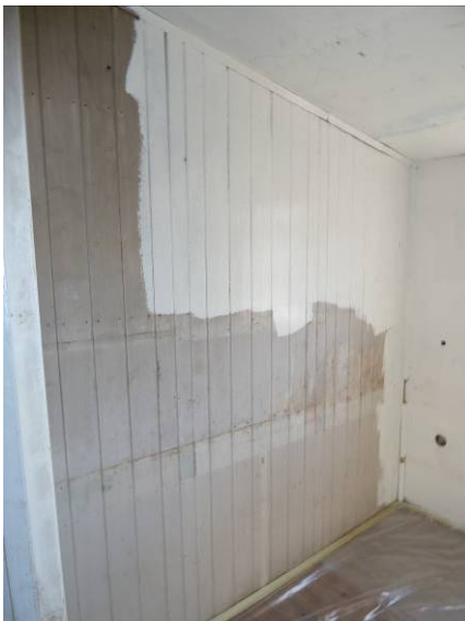
Tolvmandsbarakken blive malet fra gulv til loft indvendigt. Det tager tid, men er ikke forgæves. I midten ses også barakkens gode centrale kulovn.
