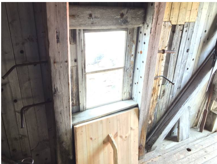
På grund af bjørnenes besøg besluttede vi at producere skodder til vinduerne for at bjørnesikre hytten bedre. Skodderne har vi sat på indvendig side af vinduerne for bedst at bevare det oprindelige udvendige udtryk.
