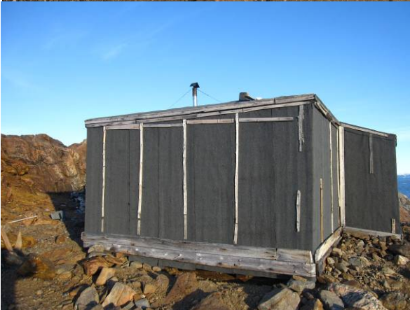
Udenpå væggenes tagpap blev derpå opsat de oprindelige lister m.m. præcist hvor de tidligere havde siddet.
