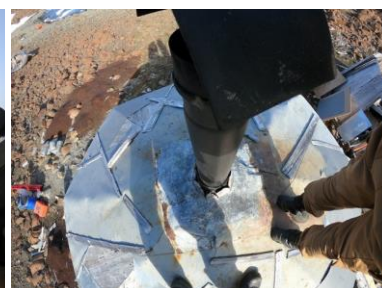
T.v. Skorstenshul. I midten: Inddækning tætnes. T.h. Gammel inddækning monteret udenpå ny.
