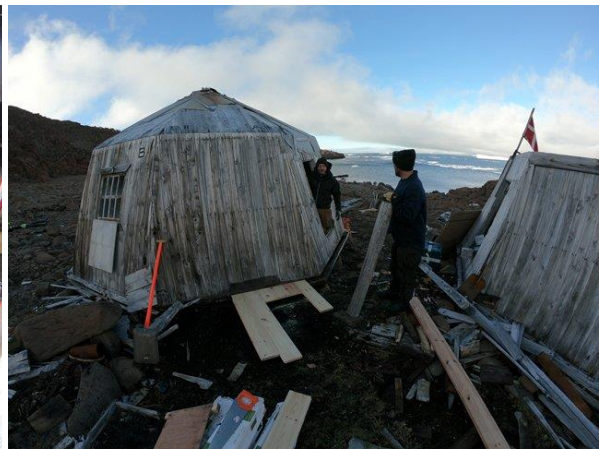
T.v. Bjælkelag forstærkes. T.h. Gulv bankes i udefra. Vægge står på gulv.
