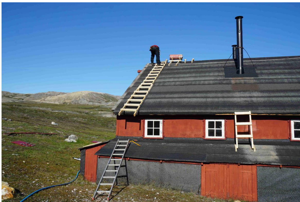
Så er arbejdet i gang med at lægge et nyt lag tagpap på Ørnereden.
