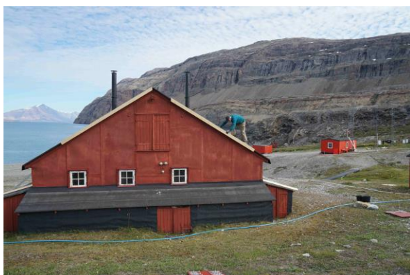
De nye vindskeder monteres og males med linoliemaling.
