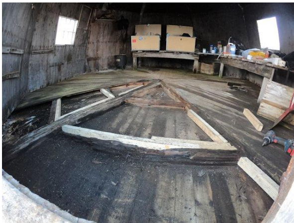
T.v. Bjælkelag forstærkes. T.h. Gulv bankes i udefra. Vægge står på gulv.
