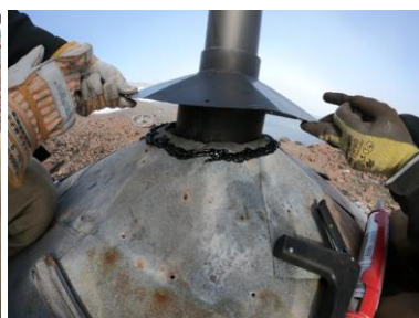
T.v. Skorstenshul. I midten: Inddækning tætnes. T.h. Gammel inddækning monteret udenpå ny.
