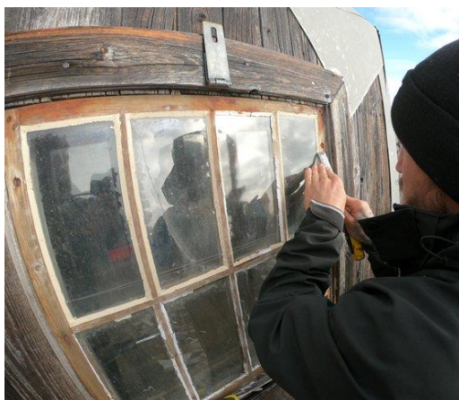
T.v. Vindueskitning. I midten: Ny yderdør monteret. T.h. Nanok renoveringsopslag.
