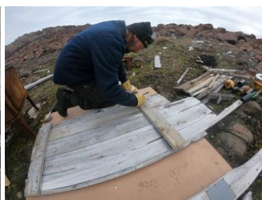
T.v. Reparation af rådskadet beklædning. I midten: Ny yderdør fabrikeres. T.h. Vandnæser monteres.
