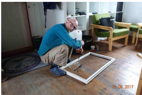
Reparation af vinduer og udskiftning af vinduesglas i Tolvmandsbarakken.
