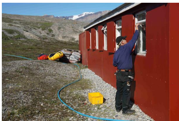
Reparation af vinduer og udskiftning af vinduesglas i Tolvmandsbarakken.
