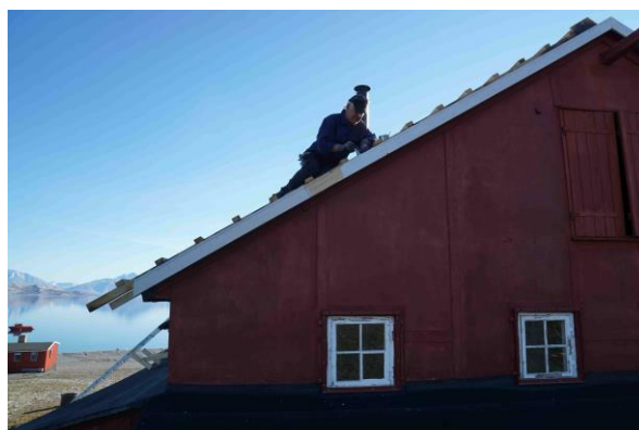
De nye vindskeder monteres og males med linoliemaling.
