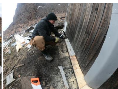
T.v. Reparation af rådskadet beklædning. I midten: Ny yderdør fabrikeres. T.h. Vandnæser monteres.
