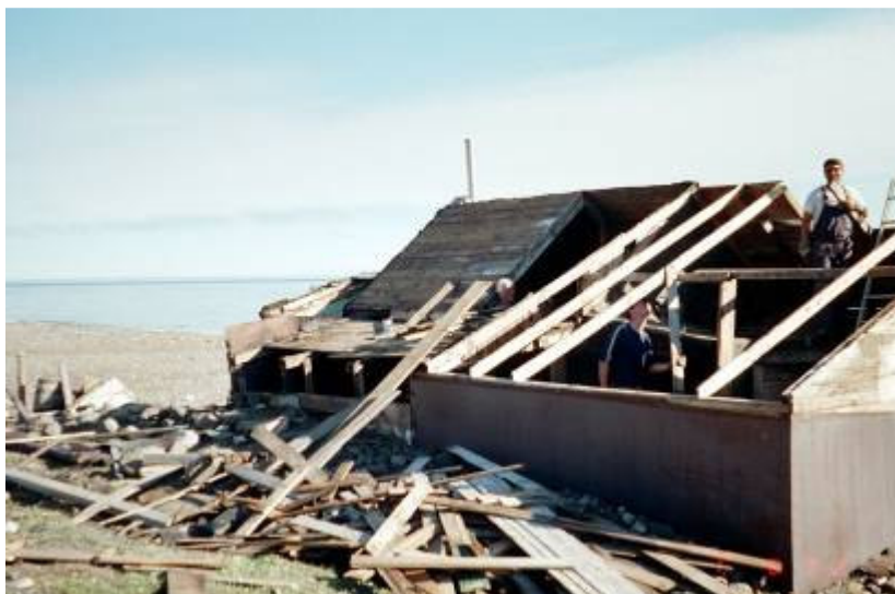
Nedtagning af det provisoriske bislag. Det indeholdt en del brugbare materialer, der kunne genanvendes
