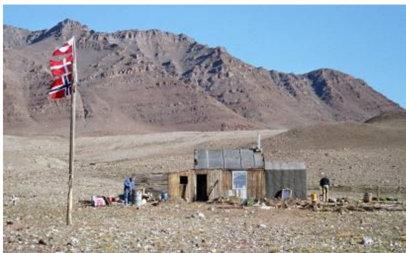
Genopbygningen er godt på vej. Væggene er repareret og inderpappen er lagt på soverummet til højre i billedet
