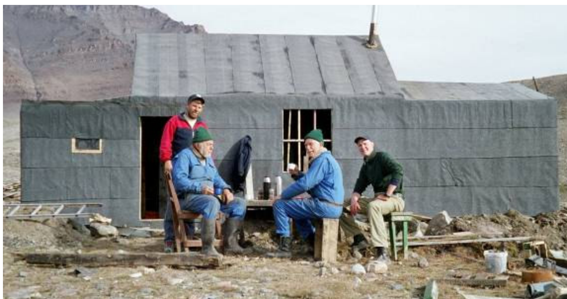
Yderpappen er lagt på veggene, men mangler endnu på taget. Underpappen blev sømmet på vertikalt og yderpappen svejset udenpå horisontalt. Fv: Knut, Ivar, Otto og Anders
