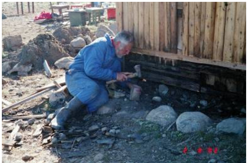
Ydervæggene særlig bag sten- og jordvoldene var rådne og måtte skiftes. Øverst og i midten: Sydvæggene efter reparation. I midten: Østvæggen før den blev istandsat. Nederst: Ivar arbejder med reparation af fundamentet
