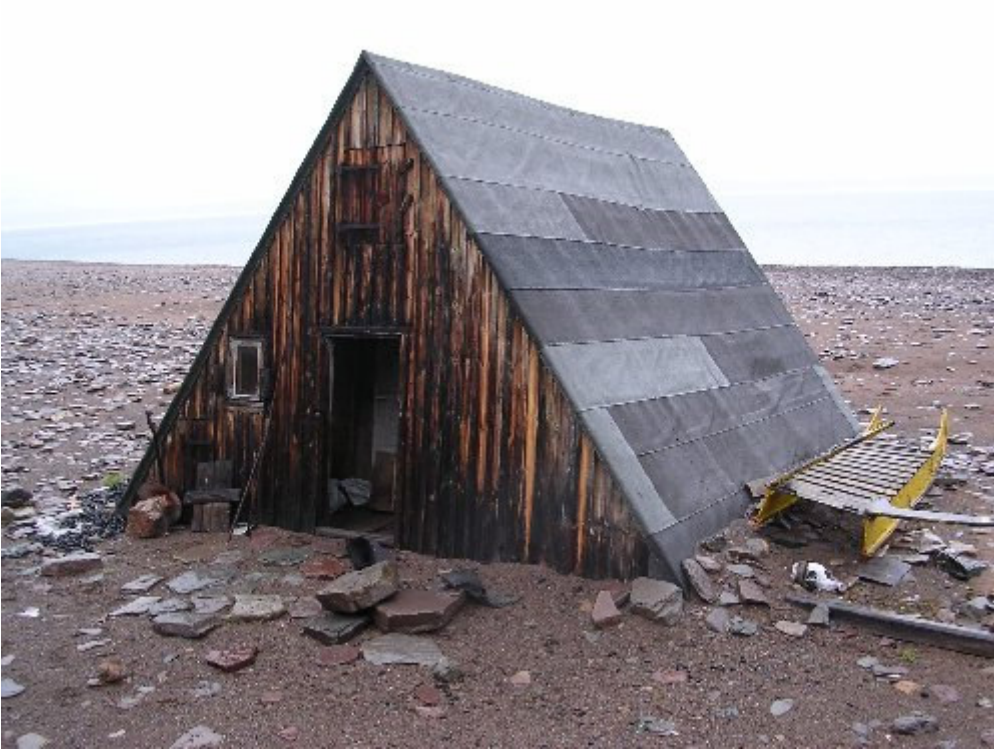
Kap Brown Huset [107].
