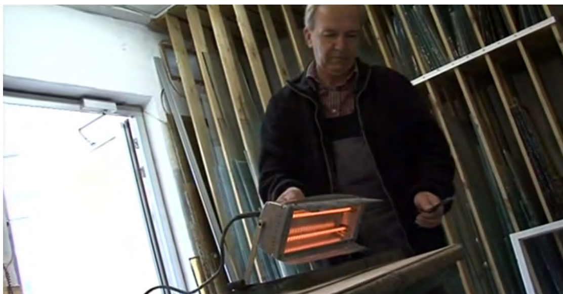
For at undgå glas og ramme ødelægges af stemmejernet bruges en kitlampe til at fjerne det gamle og hårde kit op med, så det nemt kan fjernes. Kitlampen placeres i det område hvor kittet skal fjernes og flyttes efterfølgende til det næste område der skal fjernes.
