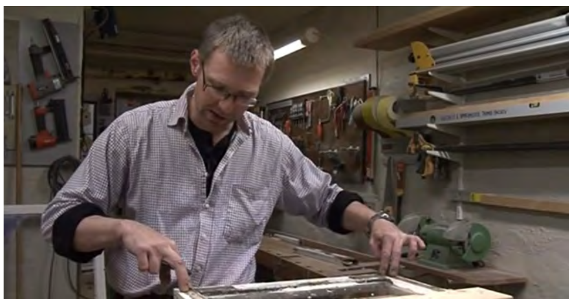
Det gamle bundstykke er blevet sømmet 2 steder for at holde det sammen medens limen tørrerede ved sidste bundrammearbejde
