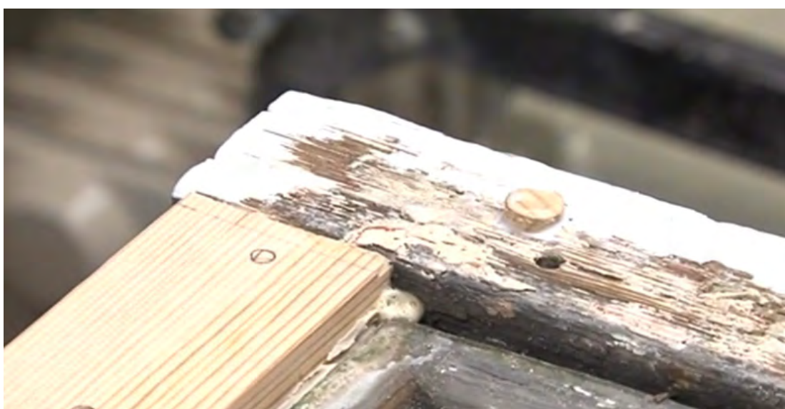
Propperne limes forsigtigt ind i skruehullerne
