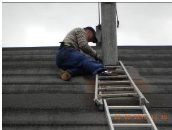
T.v. De gamle skorstensrør i Ørnereden var gennemtærede og det var blot spørgsmål om tid, før en ildebrand kunne være opstået. T.h. Kristian afmonterer den gamle skorsten.
