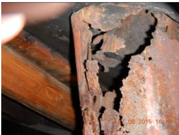
T.v. De gamle skorstensrør i Ørnereden var gennemtærede og det var blot spørgsmål om tid, før en ildebrand kunne være opstået. T.h. Kristian afmonterer den gamle skorsten.
