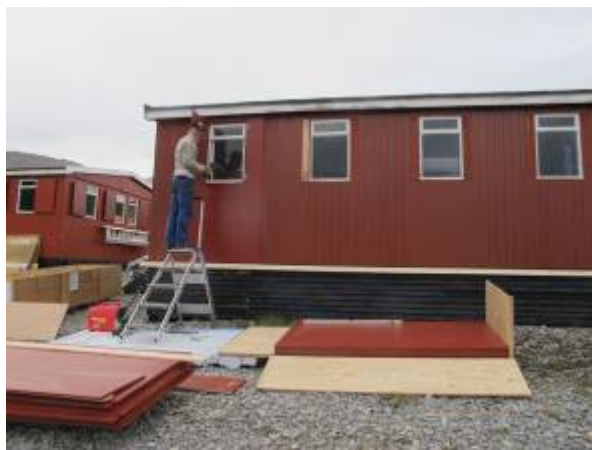
Tolv-mands-barakken blev udvendigt beklædt med krydsfinerplader, som var malet hjemmefra. Efterfølgende blev soklen nederst på huset forstærket med plader af samme type. Der blev opsat nye vinduesskodder, som også var klargjort til montage af skudrigler til lukning.
