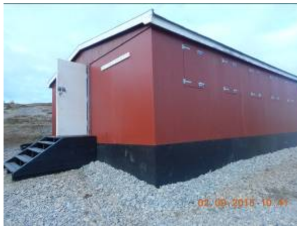
Tolv-mands-barakken blev udvendigt beklædt med krydsfinerplader, som var malet hjemmefra. Efterfølgende blev soklen nederst på huset forstærket med plader af samme type. Der blev opsat nye vinduesskodder, som også var klargjort til montage af skudrigler til lukning.
