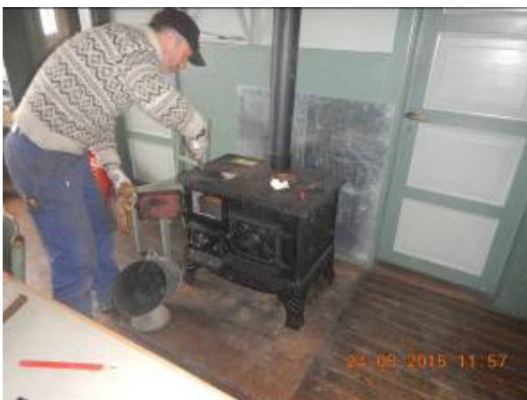
Kristian tænder op i (t.v.) og afprøver (t.h.) det nye komfur i Ørnereden. Komfuret, som Kristian har renoveret i Danmark, er formentlig det originale fra Ørnereden.
