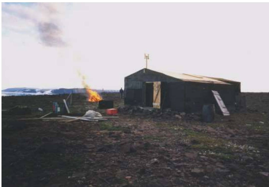
Det gamle rådne træ fra tag og loft afbrændes. Rådne brædder udskiftes og taget gøres tæt med krydsfinerplader.
