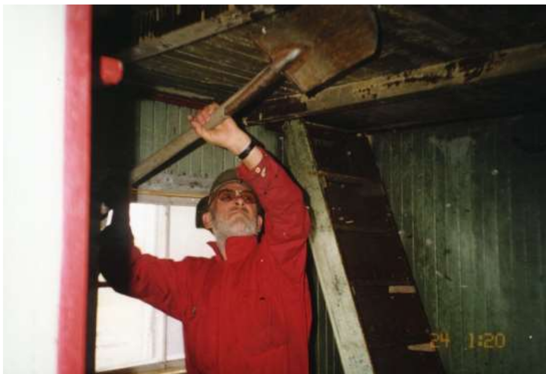
Øystein renser kjøkkenloftet for skidt og løs maling.
