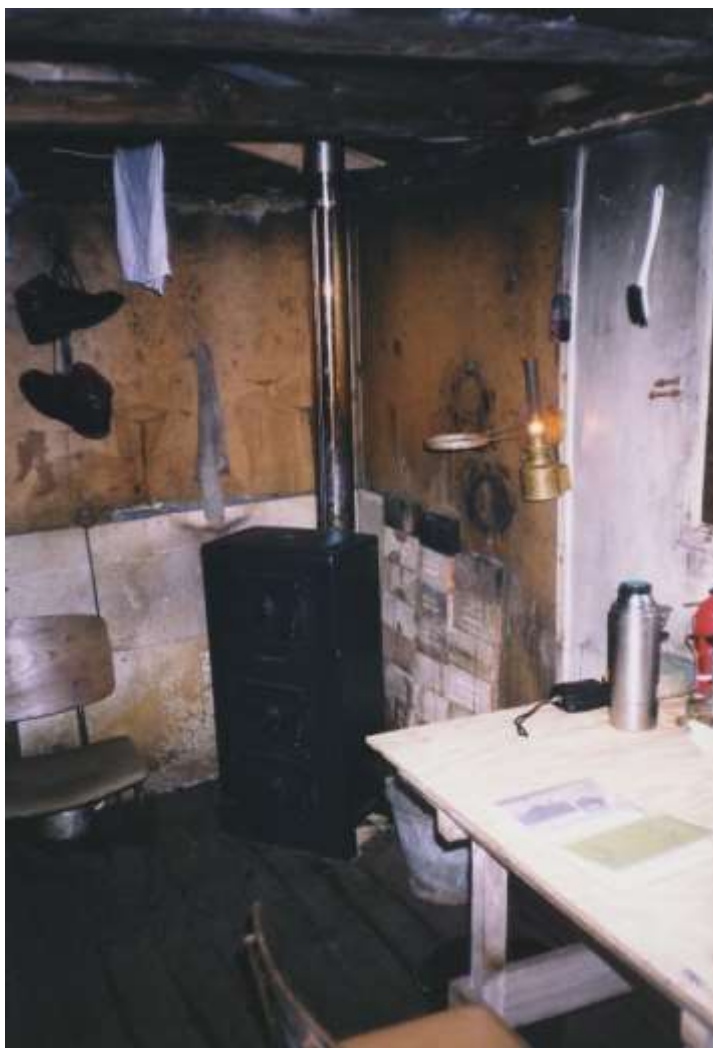
En ny brændeovn er sat til erstatning for den gamle ubrugelige. Ovnens lov at køre på fuld tryk, så huset blev tørt godt ud. Den gamle loftbeklædning er revet ned, så bjælkerne nu er synlige. Gulv og vægge er vasket af for mug og snavs.
