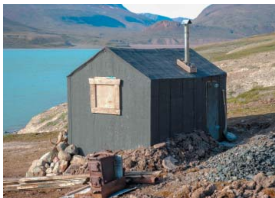
Halle [341] efter renovering og med genopbygget fundament, 11. august 2011.
