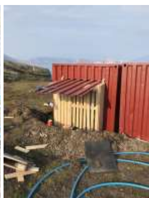
T.v.: Der graves - hvem behøver et fitnesscenter? I midten: Container er åbnet med vinkelsliber og bruges som tag til tilbygning. T.h.: Tilbygning på 'bådhuset'. Der er lagt pap og drænet rundt om containeren og fuget så den skulle være snetæt. Også monteret vejrstation med indbygget solceller.
