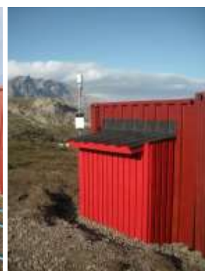
T.v.: Der graves - hvem behøver et fitnesscenter? I midten: Container er åbnet med vinkelsliber og bruges som tag til tilbygning. T.h.: Tilbygning på 'bådhuset'. Der er lagt pap og drænet rundt om containeren og fuget så den skulle være snetæt. Også monteret vejrstation med indbygget solceller.
