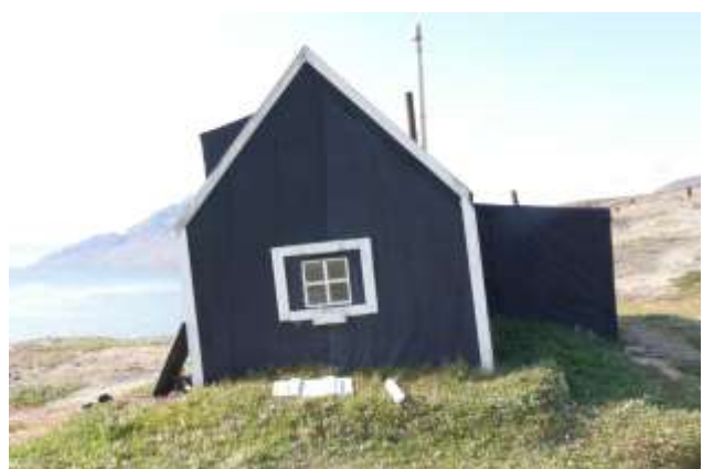
Hoelsbu [356]. Huset hælder nu så meget, at Nanok påtænker en genopretning i 2021.
