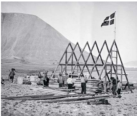
Nordfjordhuset [358-2] under opførelse, august 1931. © Arktisk Institut
