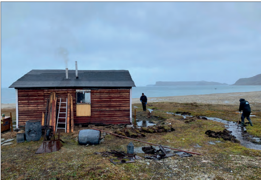
T.v.: Dræning af hyttens omgivelser. T.h.: Tætning af tagkonstruktion mod regn og fygesne.
