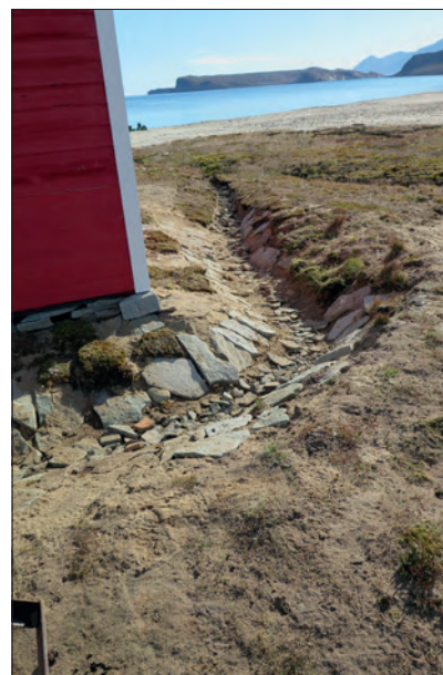
T.v.: Maling af hyttens yderbeklædning. I midten og t.h.: Færdiggørelse af grøfter. Dele af nyt omfangsdræn.
