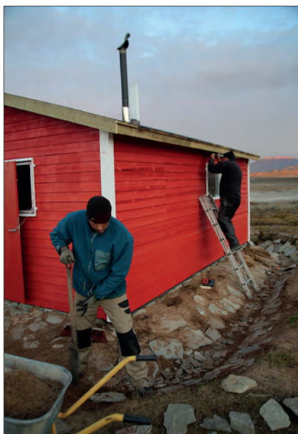
T.v.: Maling af hyttens yderbeklædning. I midten og t.h.: Færdiggørelse af grøfter. Dele af nyt omfangsdræn.
