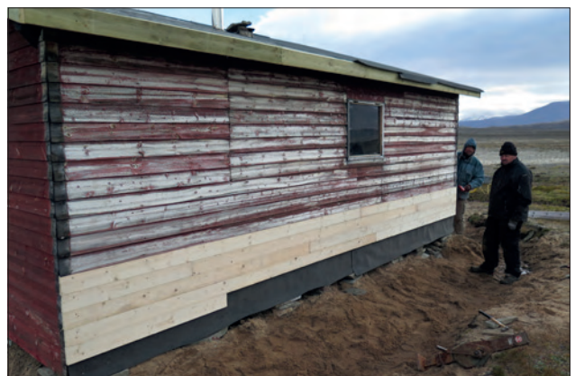
T.v.: Pålægning af nyt tagpap. T.h.: Ny bræddebeklædning på hyttens bagside.
