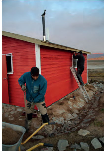
T.v.: Maling af hyttens yderbeklædning. I midten og t.h.: Færdiggørelse af grøfter. Dele af nyt omfangsdræn.
