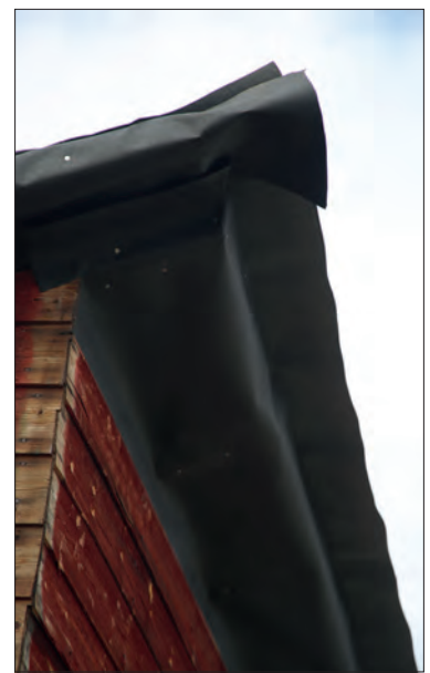
T.v.: Dræning af hyttens omgivelser. T.h.: Tætning af tagkonstruktion mod regn og fygesne.
