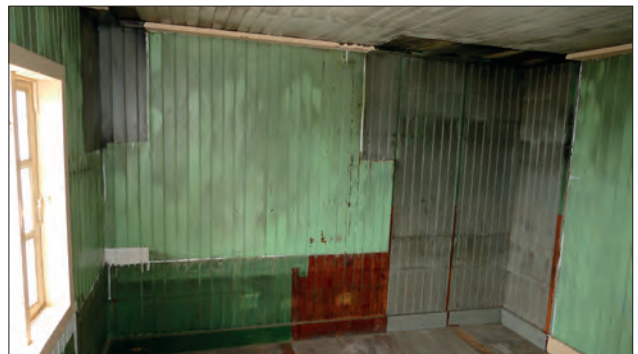
Fjernelse af masonitbeklædning og indbyggede skabe/køjer i stuerummet. Bag masonitten kommer de fine, gamle panelvægge igen til syne - med forskellige lag af bemalinger.
