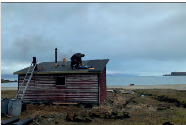
T.v.: Pålægning af nyt tagpap. T.h.: Ny bræddebeklædning på hyttens bagside.
