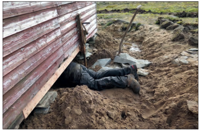
Renovering af Hamna. T.v.: Dræning og opklodsning. T.h.: Opklodsning af hyttens midte.
