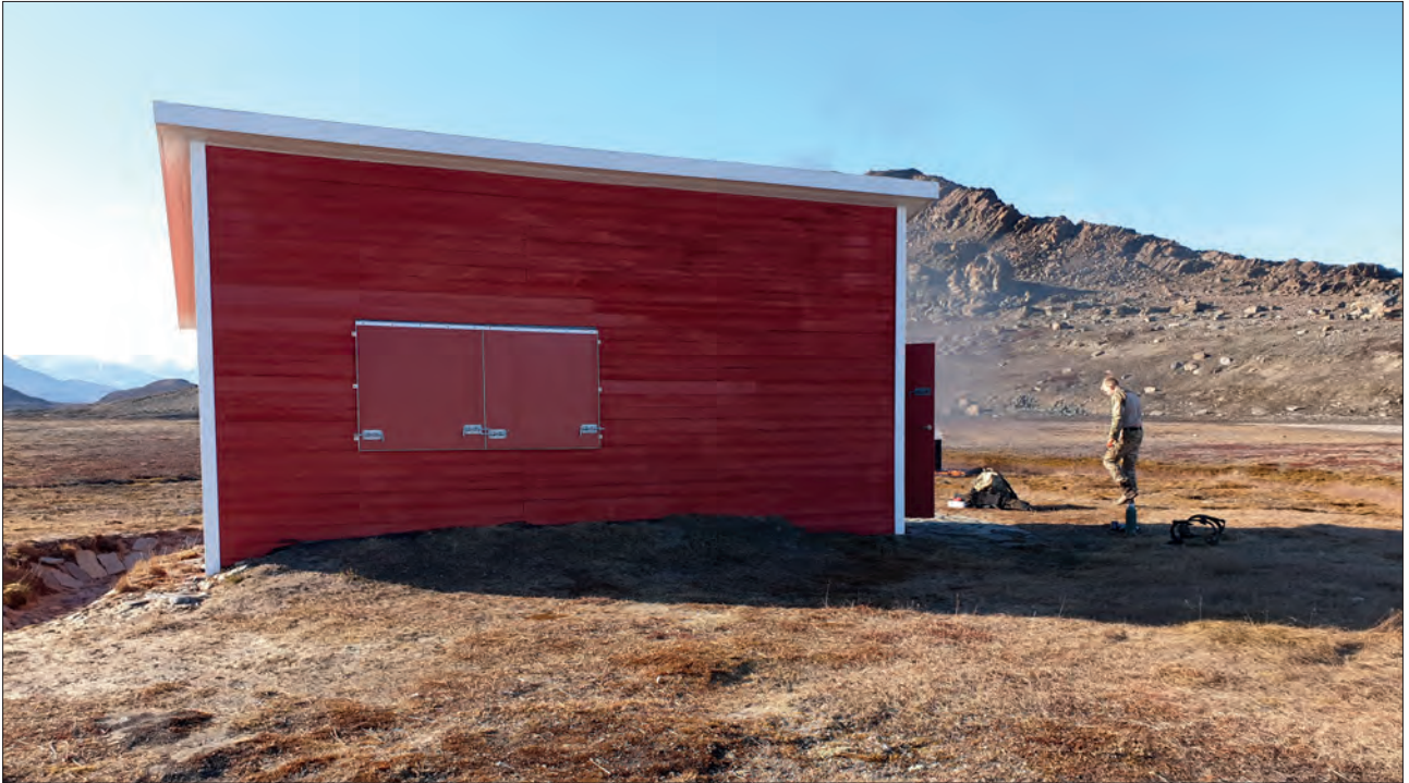
Færdigt arbejde. Tårnuglerne i Mestersvig har sørget for maling af den sidste del af fronten.
