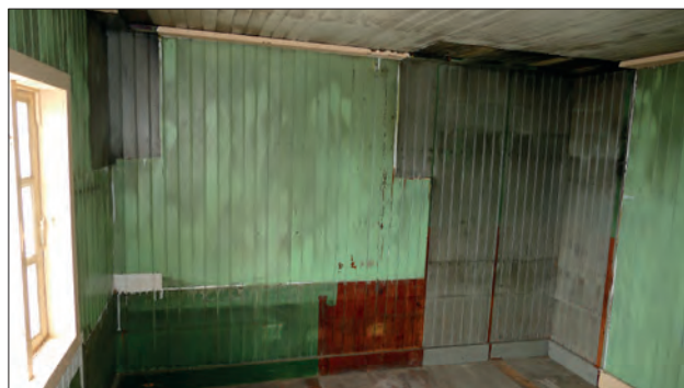
Fjernelse af masonitbeklædning og indbyggede skabe/køjer i stuerummet. Bag masonitten kommer de fine, gamle panelvægge igen til syne - med forskellige lag af bemalinger.
