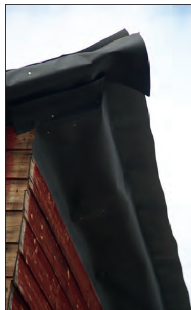
T.v.: Dræning af hyttens omgivelser. T.h.: Tætning af tagkonstruktion mod regn og fygesne.
