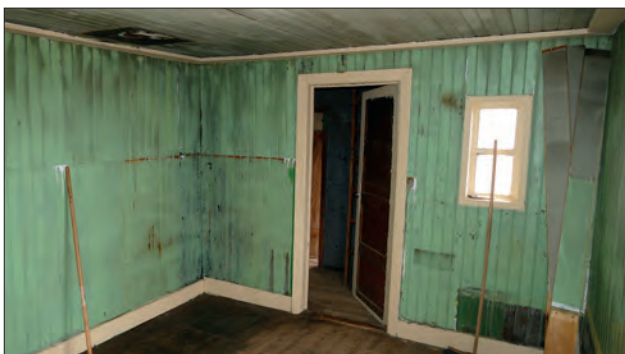
Fjernelse af masonitbeklædning og indbyggede skabe/køjer i stuerummet. Bag masonitten kommer de fine, gamle panelvægge igen til syne - med forskellige lag af bemalinger.
