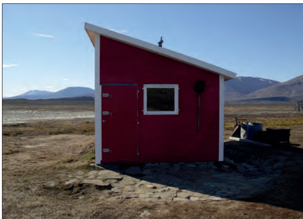
T.v.: Ny yderbeklædning, belægning og omfangsdræn. T.h.: Opholdsrummet efter renovering.
