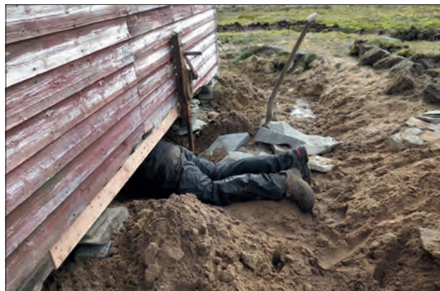
Renovering af Hamna. T.v.: Dræning og opklodsning. T.h.: Opklodsning af hyttens midte.
