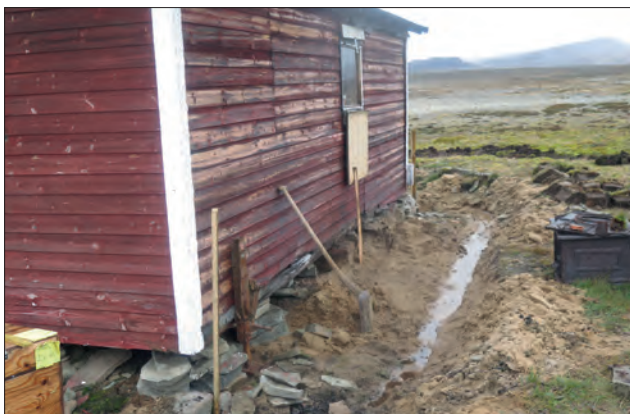
Renovering af Hamna. T.v.: Dræning og opklodsning. T.h.: Opklodsning af hyttens midte.
