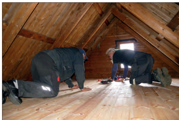
I loftsrummet fjernes det gamle gulv og erstattes af et helt nyt plankegulv.
