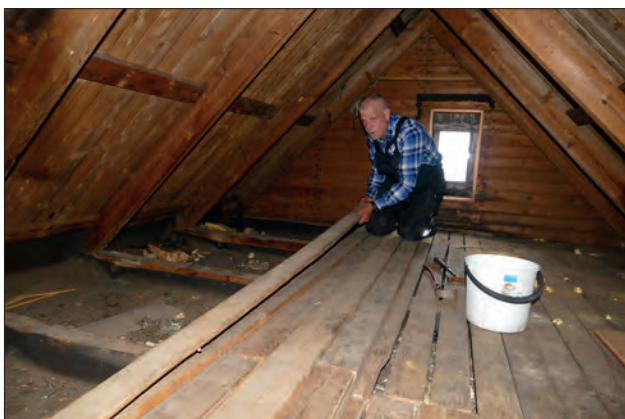
I loftsrummet fjernes det gamle gulv og erstattes af et helt nyt plankegulv.
