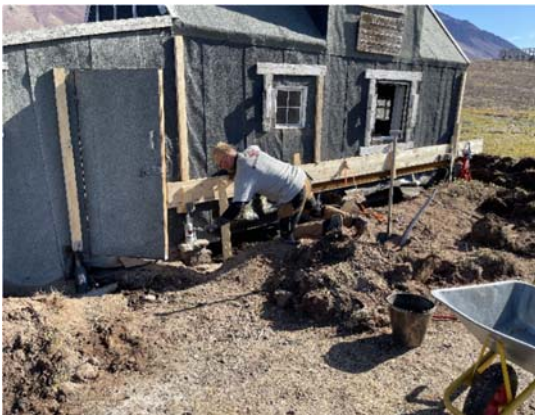
Genopretningen af Hoelsbu i fuld gang. Kraftige I-stålprofiler kiles ind under huset for at skabe et solidt fundament.
