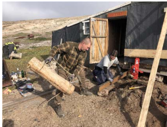
Genopretningen af Hoelsbu i fuld gang. Kraftige I-stålprofiler kiles ind under huset for at skabe et solidt fundament.
