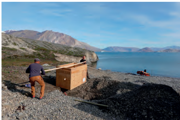
”Agsut” får ny vinterplads på Nanoks areal. Støbekassen til fundamentet til ophaler-spillet placeres.
