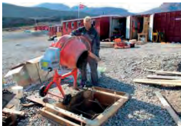
Støbning af fundament til det nye ophalerspil til "Agsut".
