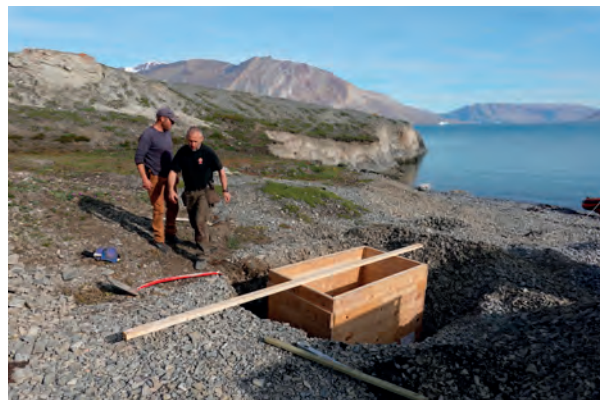
”Agsut” får ny vinterplads på Nanoks areal. Støbekassen til fundamentet til ophaler-spillet placeres.
