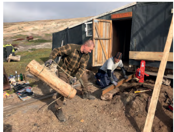
Genopretningen af Hoelsbu i fuld gang. Kraftige I-stålfiler kiles ind under huset for at skabe et solidt fundament.
