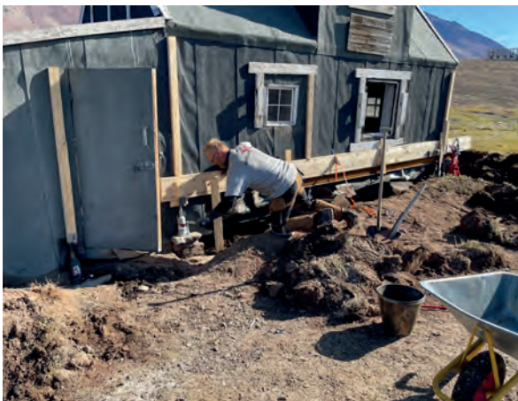
Genopretningen af Hoelsbu i fuld gang. Kraftige I-stålfiler kiles ind under huset for at skabe et solidt fundament.
