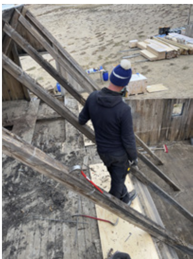
Reparation af den bærende konstruktion i husets østside. Isolering og papning af taget.
