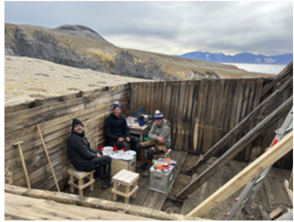
Renoveringen er i gang. Det var nødvendigt at fjerne taget på husets østside for at renovere den bærende konstruktion.
