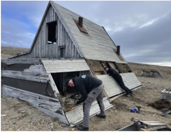
Renoveringen er i gang. Det var nødvendigt at fjerne taget på husets østside for at renovere den bærende konstruktion.
