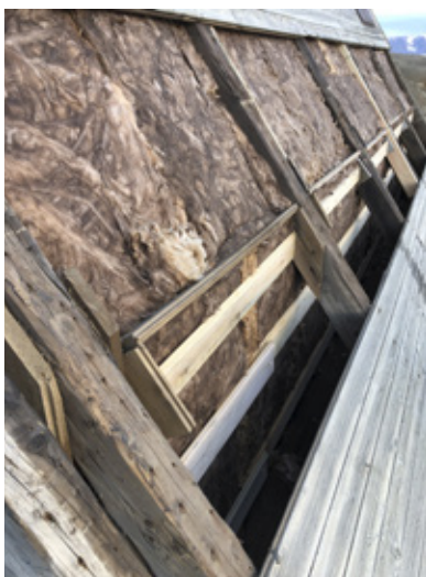
Reparation af den bærende konstruktion i husets østside. Isolering og papning af taget.
