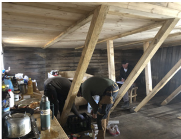
Den bærende konstruktion er nu istandsat. Gulve og loft bliver istandsat under næste fase - i 2023.
