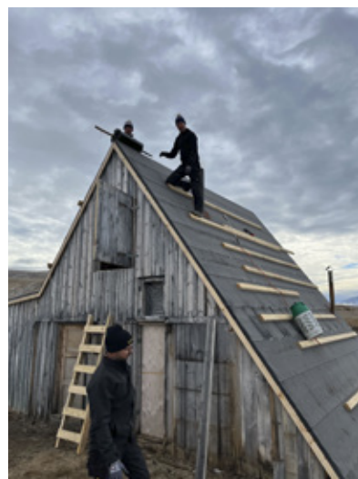
Reparation af den bærende konstruktion i husets østside. Isolering og papning af taget.
