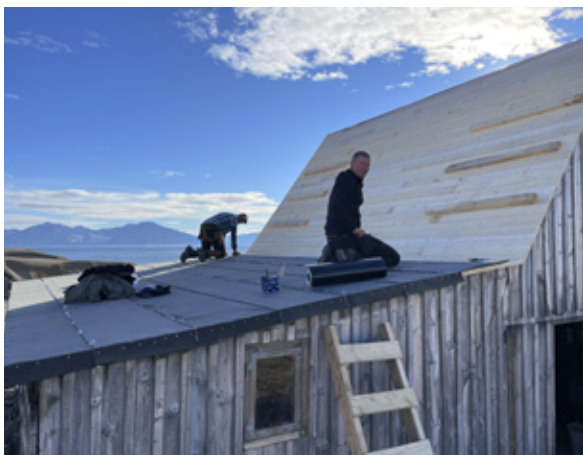
T.v.: Der lægges tagpap på taget. T.h.: Det nye loftsgulv.
