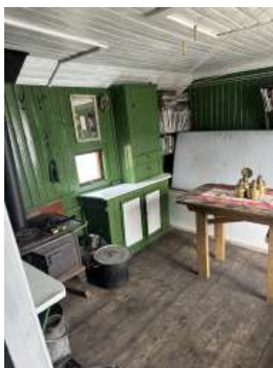
I soveværelset og stue/køkken blev væggene vasket og derefter malet med grøn lindoliemaling, så det nu ligner den oprindelige farve. Loftet fik også en ny gang hvid maling.
