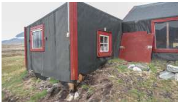
Udenfor blev soklen gravet fri, så der kunne brændes nyt tagpap på, inden der igen blev afdækket.
