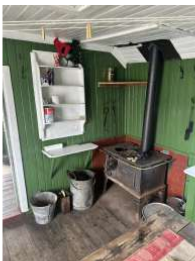
I soveværelset og stue/køkken blev væggene vasket og derefter malet med grøn lindoliemaling, så det nu ligner den oprindelige farve. Loftet fik også en ny gang hvid maling.
