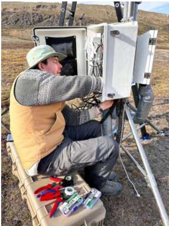
Johan i gang med montagearbejdet.
