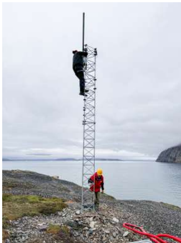
Atmosfæremasten er tømt for udstyr og næsten klar til at blive lagt ned.
