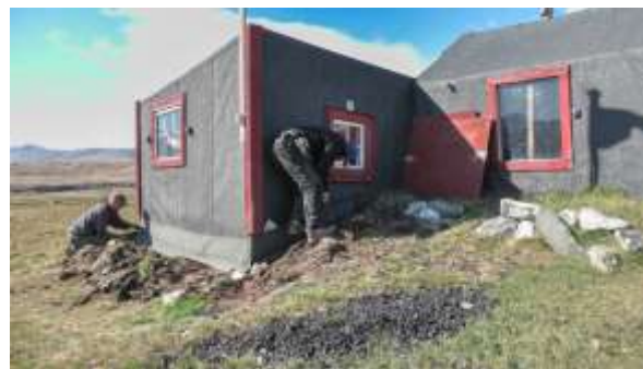
Udenfor blev soklen gravet fri, så der kunne brændes nyt tagpap på, inden der igen blev afdækket.
