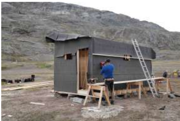
Montering af vægge og vinduer og beklædning med tagpap.
